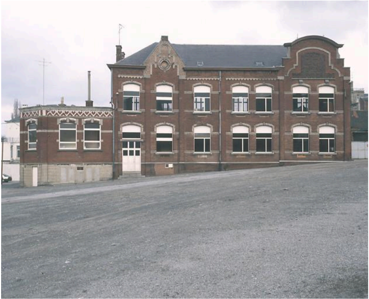
Élévation antérieure de l'aile méridionale.
