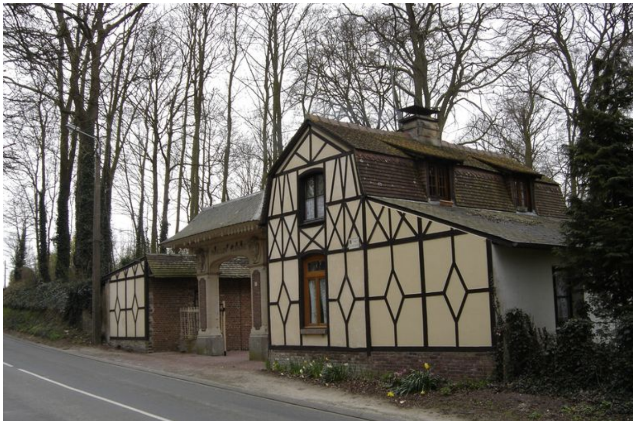
Vue générale de l'entrée située sur le hameau de Pinchefalise.
