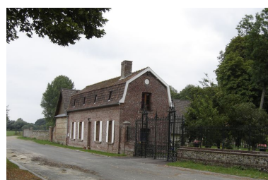
Vue du mur de clôture sur la rue de l'Eglise et conciergerie.
