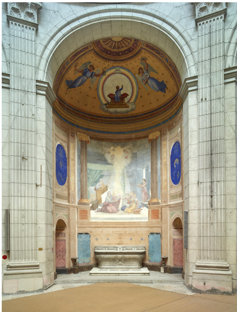
Vue générale, après restauration.
