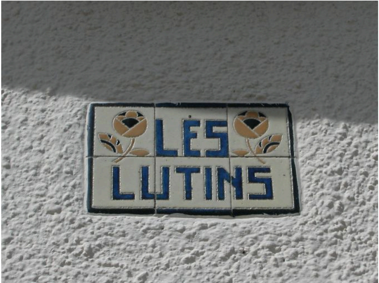
Détail du carreau de céramique portant appellation.
