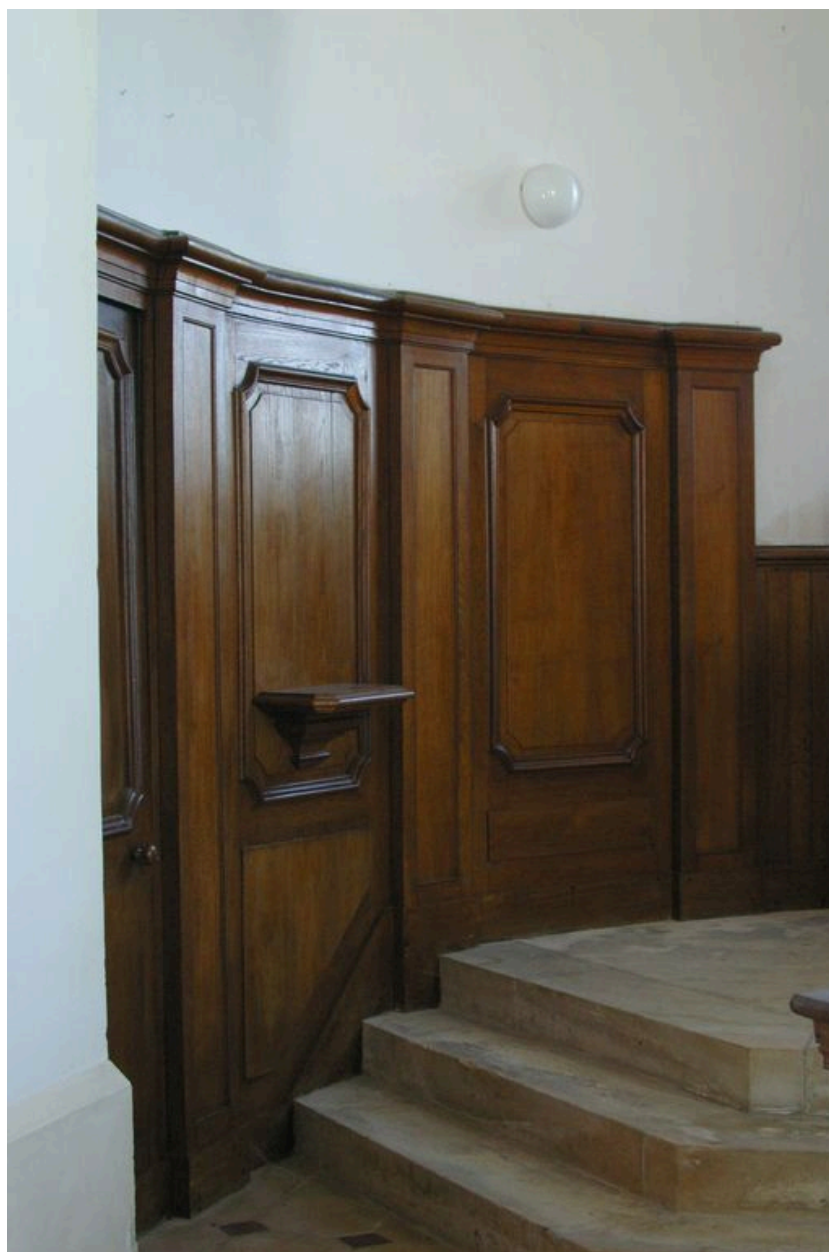
Vue des lambris de demi-revêtement du chœur.
