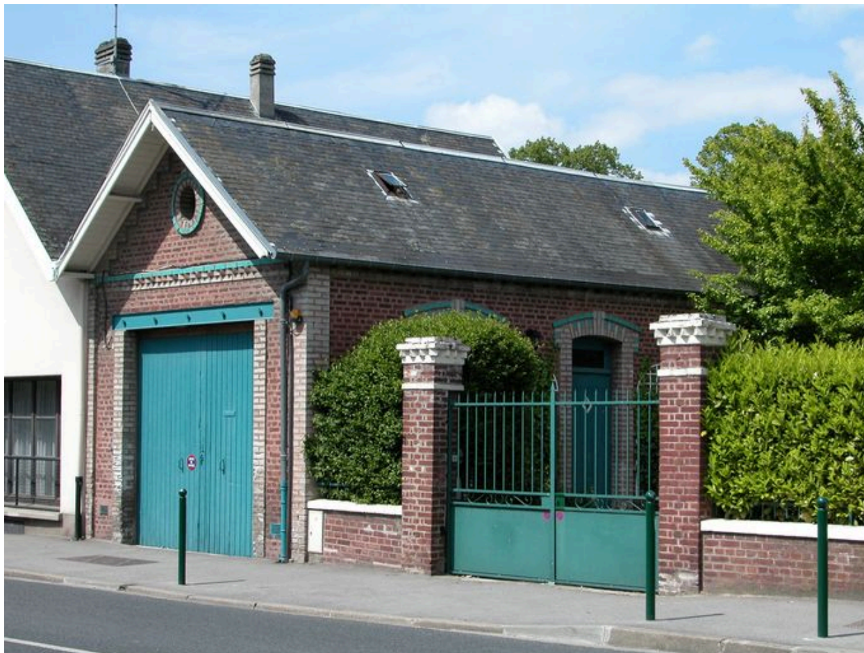
Le garage isolé, à l'aplomb du quai du Romerel.
