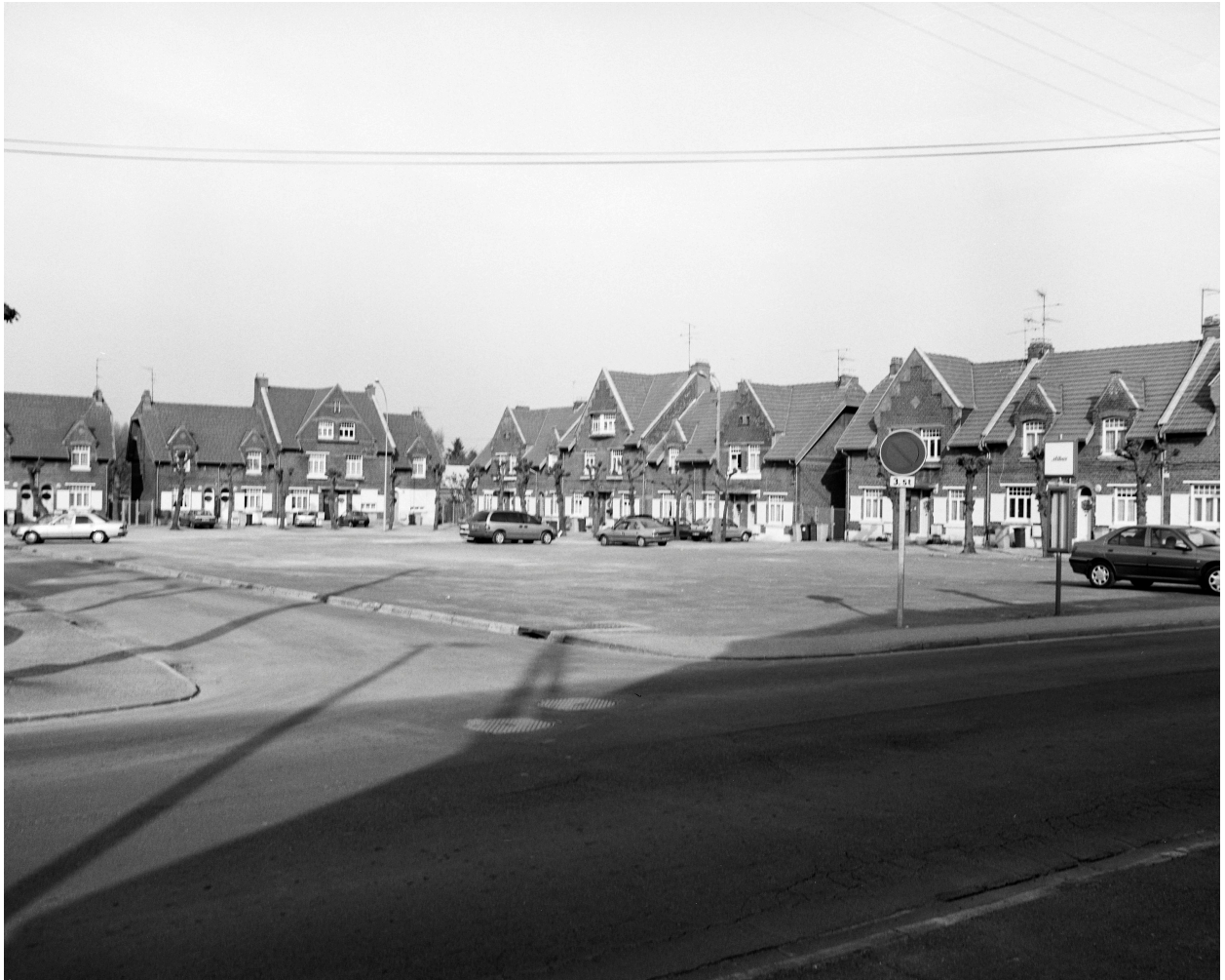
Vue générale du lotissement, l'aile sud et est.
