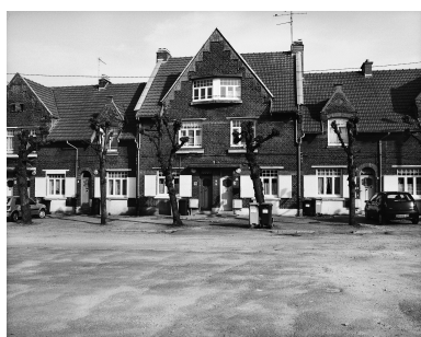
Vue partielle du deuxième groupe de maisons, aile sud. Phot. Thierry Petitberghien IVR31_20025901217X
