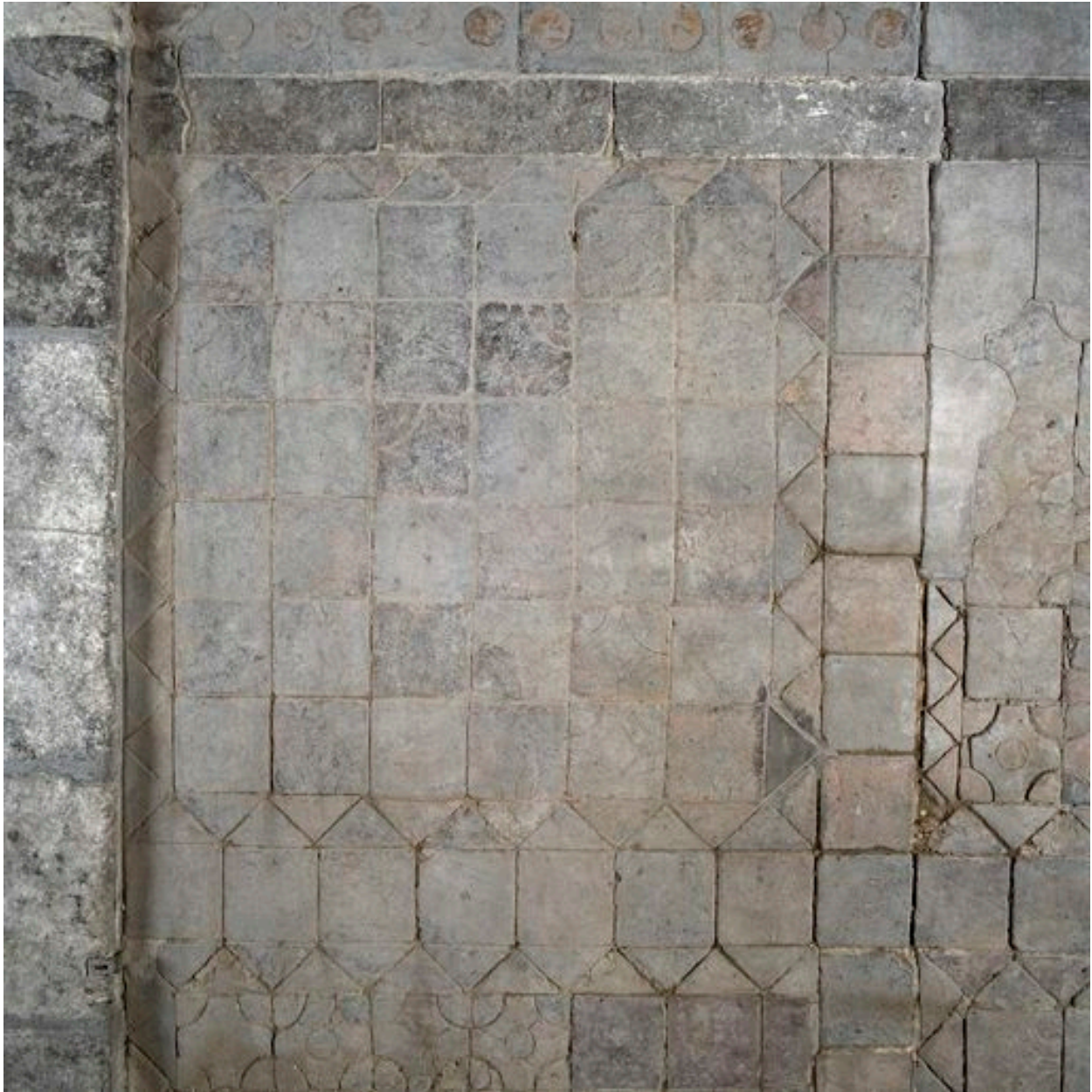
Détail du carrelage.
