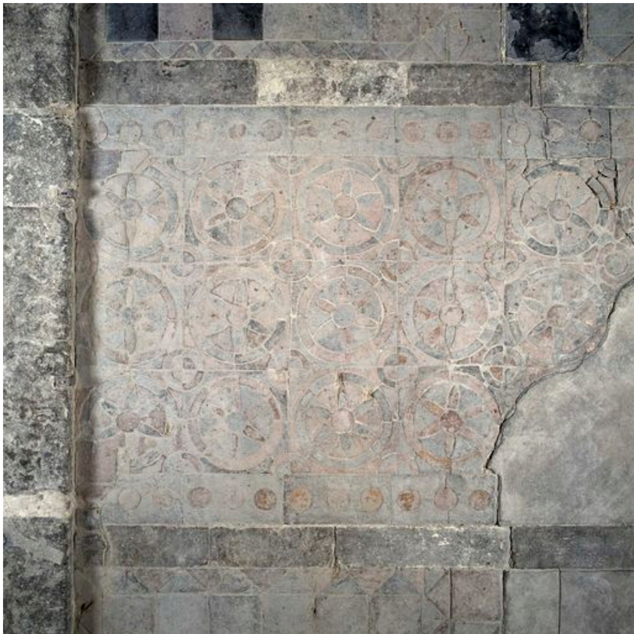
Détail du carrelage.
