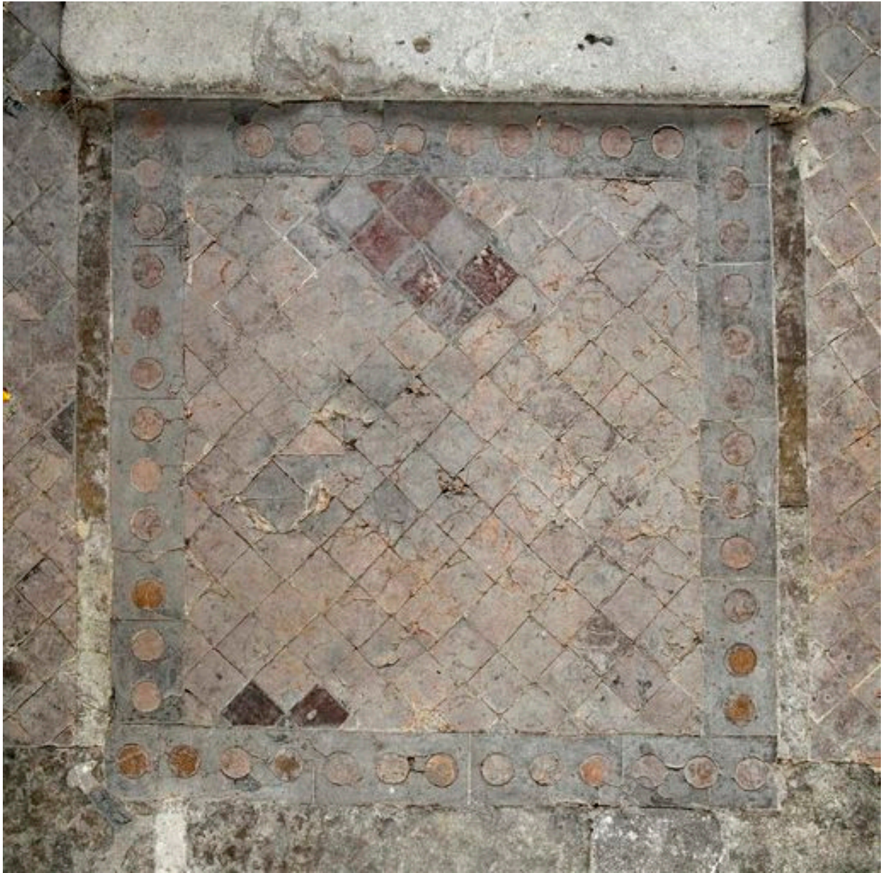
Détail du carrelage.
