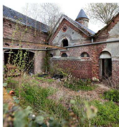
Les dépendances agricoles. Phot. Hubert Bouvet IVR31_20105900084NUCA
