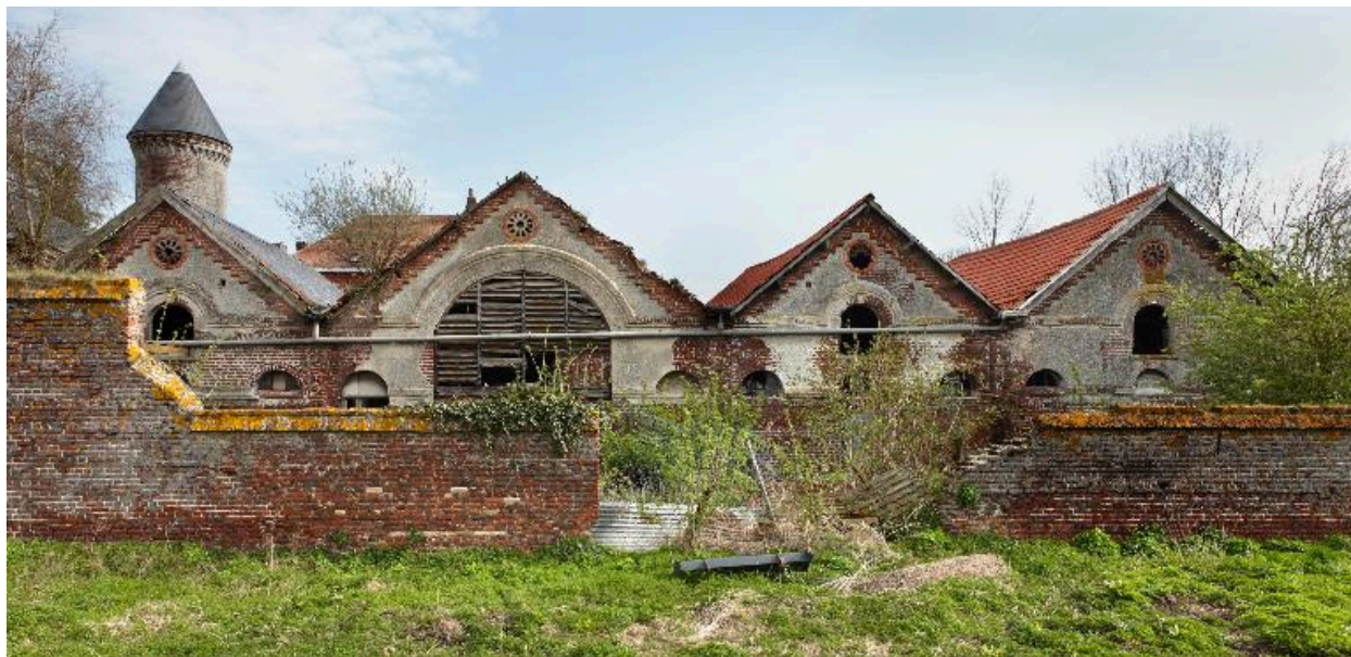
Vue générale des dépendances.
