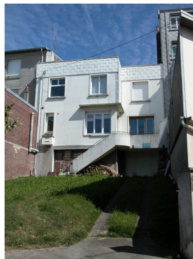
Façade postérieure, vue depuis la rue de la Plaine. Phot. Elisabeth Justome IVR22_20058003522NUCA
