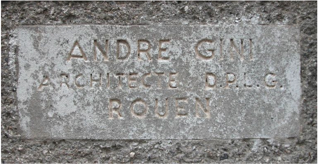
Détail de la signature du maître d'oeuvre, gravée en creux, située à la base du mur.
