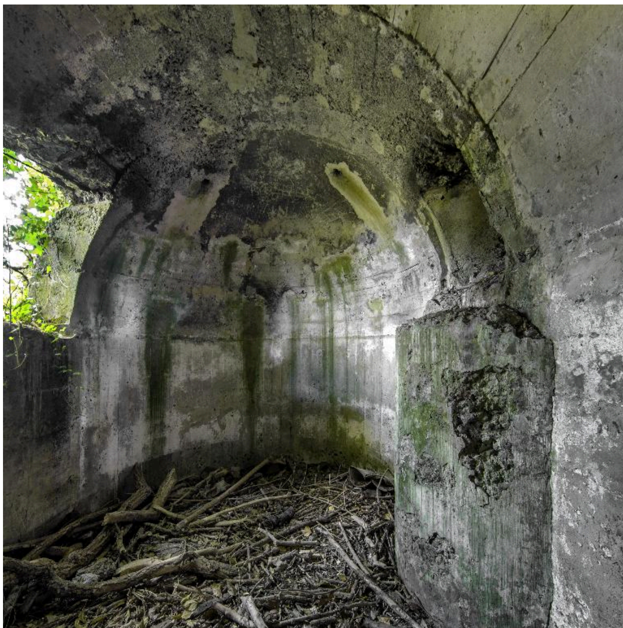
Vue interieur de l'édifice, vers le sud-est
