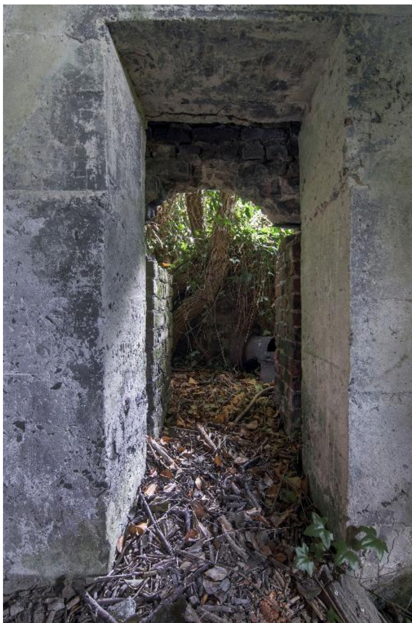
Couloir de sortie de l'édifice, vers le nord ouest
