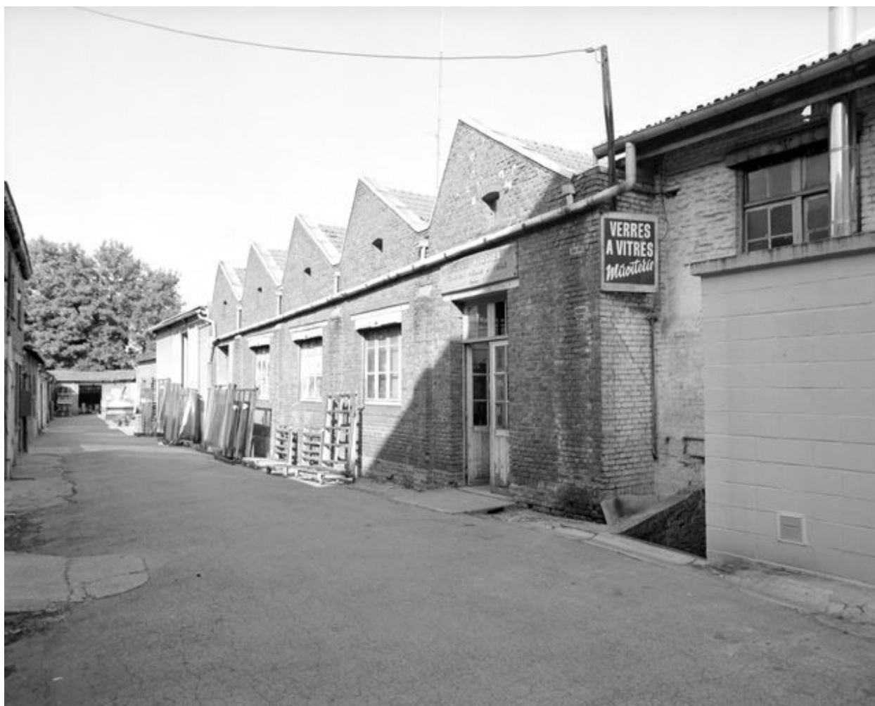
Vue de l'atelier de fabrication, élévation ouest.
