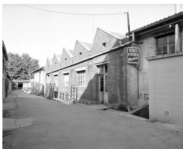
Vue de l'atelier de fabrication, élévation ouest. Phot. Thierry Lefébure IVR22_19898000397X
