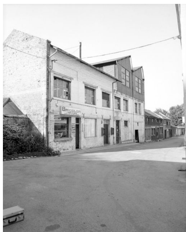
Atelier de fabrication ouest, élévation est. Phot. Thierry Lefébure IVR22_19898000395X
