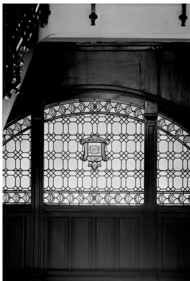
Vitrage de la cage d'escalier de l'entresol, Pradel, Asnières, 1891, 1893 : vue d'un détail. Phot. Thierry Lefébure IVR22_19900201773X
