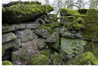
Elévation nord-est Phot. Jean-Marc Ramette IVR31_20145904420NUCA
