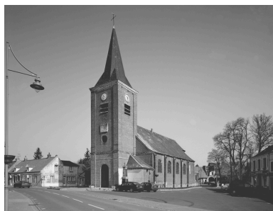
Vue générale extérieure, depuis la rue. Phot. Philippe Dapvril IVR31_20045900160V
