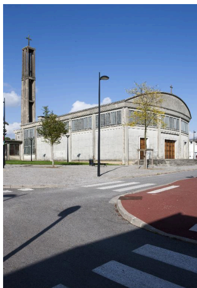
Vue de trois quarts gauche de l'église avec son clocher. Phot. Pierre Thibaut IVR31_20155900095NUCA
