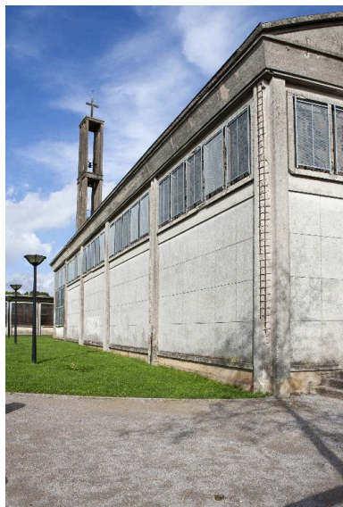
Élévation du flanc gauche de l'église. Phot. Pierre Thibaut IVR31_20155900077NUCA
