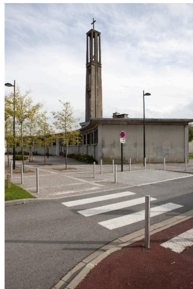
Vue extérieure des salles paroissiales à gauche de l'église et façade postérieure. Phot. Pierre Thibaut IVR31_20155900075NUCA
