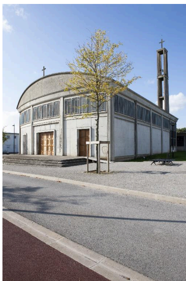
Vue de trois quarts de l'élévation antérieure et du flanc droit. Phot. Pierre Thibaut IVR31_20155900096NUCA
