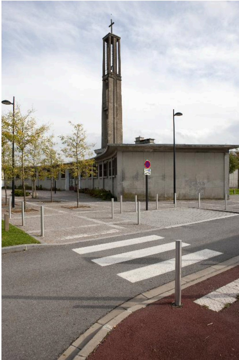
Vue extérieure des salles paroissiales à gauche de l'église et façade postérieure.
