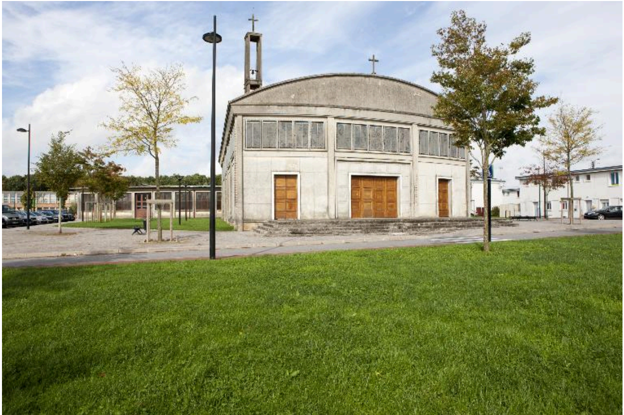
Élévation de trois quarts gauche de la façade antérieure.
