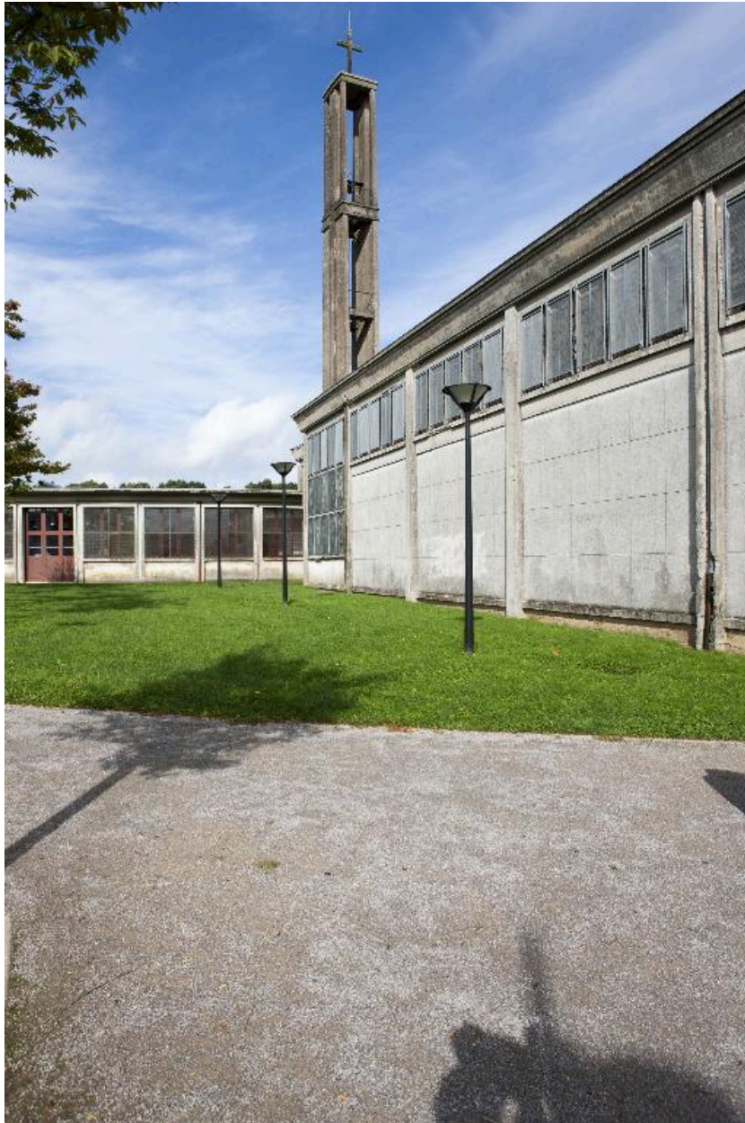
Élévation du flanc gauche de l'église et salles paroissiales.
