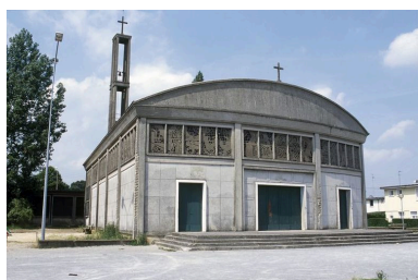
Vue générale des élévations ouest et sud. Phot. Pierre Thibaut IVR31_20005901457ZA
