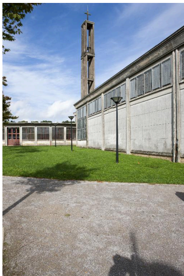
Élévation du flanc gauche de l'église et salles paroissiales. Phot. Pierre Thibaut IVR31_20155900071NUCA
