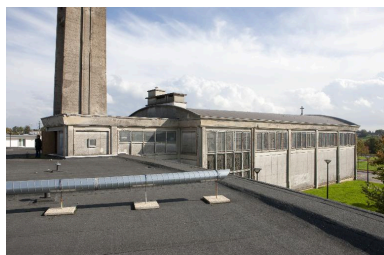
Élévation du flanc gauche de l'église depuis la terrasse couvrant les salles paroissiales. Phot. Pierre Thibaut IVR31_20155900078NUCA
