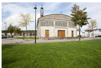
Élévation de trois quarts gauche de la façade antérieure. Phot. Pierre Thibaut IVR31_20155900069NUCA
