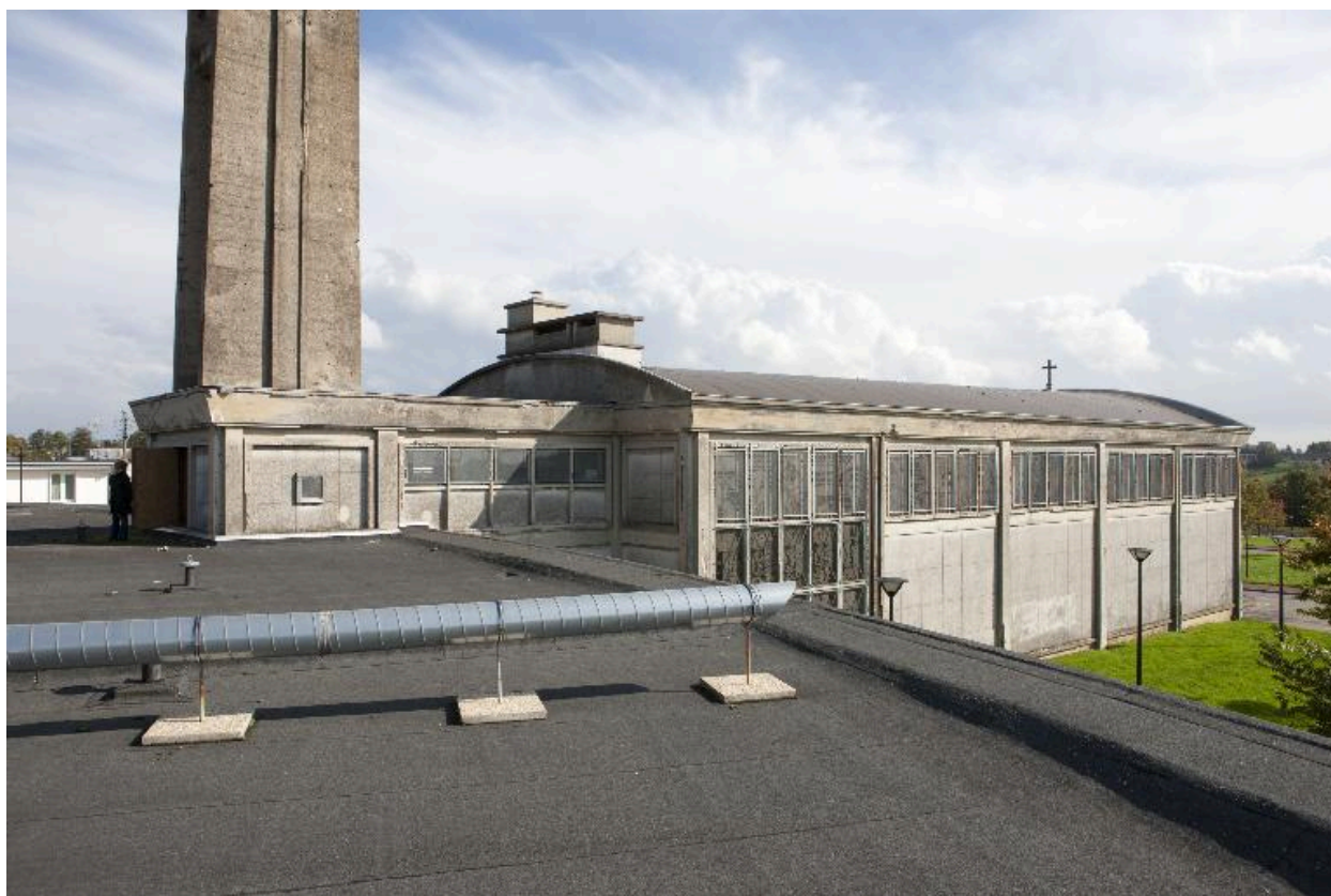
Élévation du flanc gauche de l'église depuis la terrasse couvrant les salles paroissiales.
