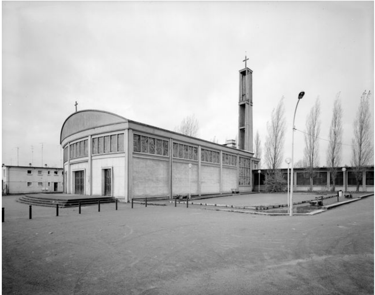
Vue des façades sud et est.
