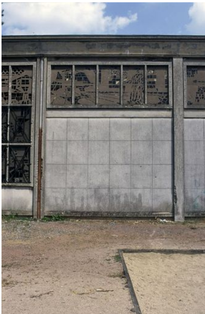
Vue partielle de l'élévation ouest.
