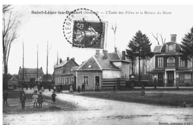
Vue générale depuis la place publique, vers 1910 (coll. part.). Phot. Fournier Bertrand (reproduction) IVR22_20088015054NUCA
