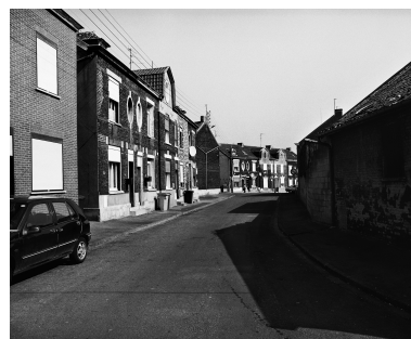
Vue générale de la cité. Phot. Thierry Petitberghien IVR31_20025901207X
