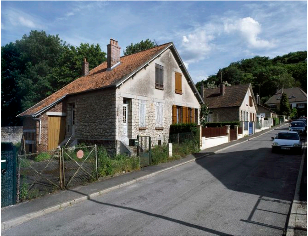
Vue générale de la cité Claude-Primet.
