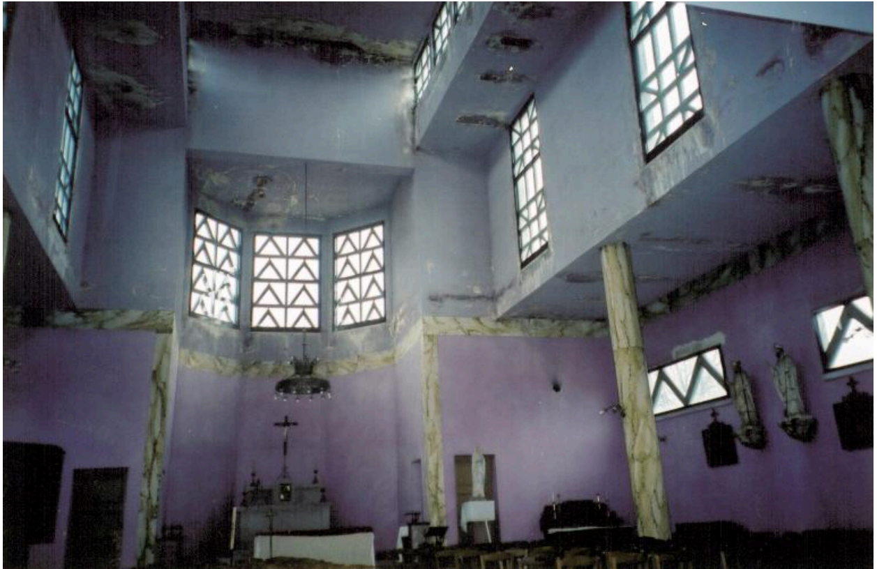
Vue intérieure vers le chœur.
