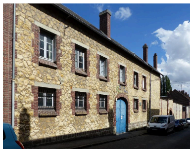
Vue de l'ancienne maison conventuelle. Phot. Isabelle Barbedor IVR32_20178005229NUCA
