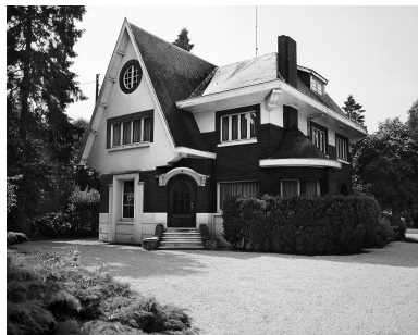
Élévation de trois quarts. Phot. Olivier Marlard IVR31_19955900509X
