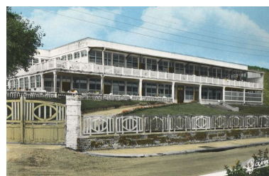
Bâtiment affecté aux femmes dit Institut hélio-marin B, élévation antérieure prise depuis la rue, vue
