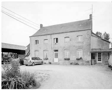
Vue du logis. Phot. Pierre Thibaut IVR31_20055900650V
