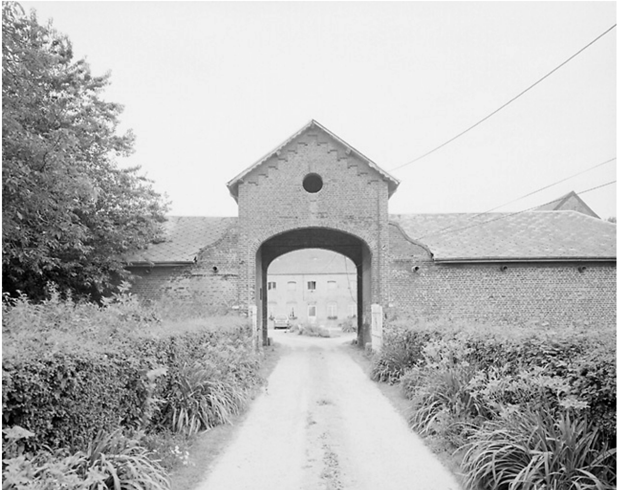
Vue générale du porche d'entrée.
