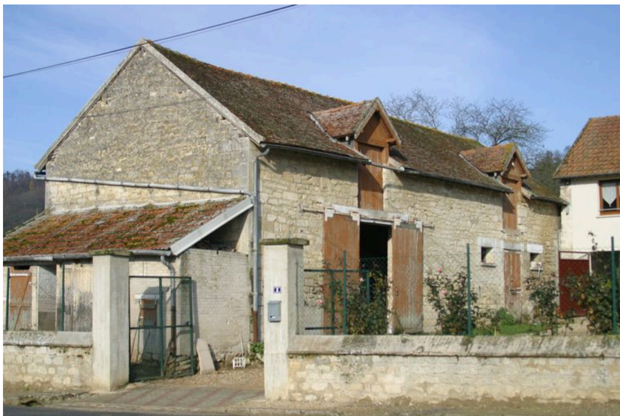
Vue de la grange.
