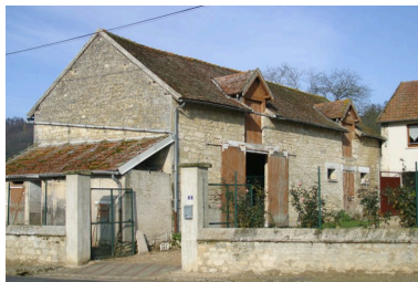
Vue de la grange. Phot. Inès Guérin IVR22_20030202099NUCA
