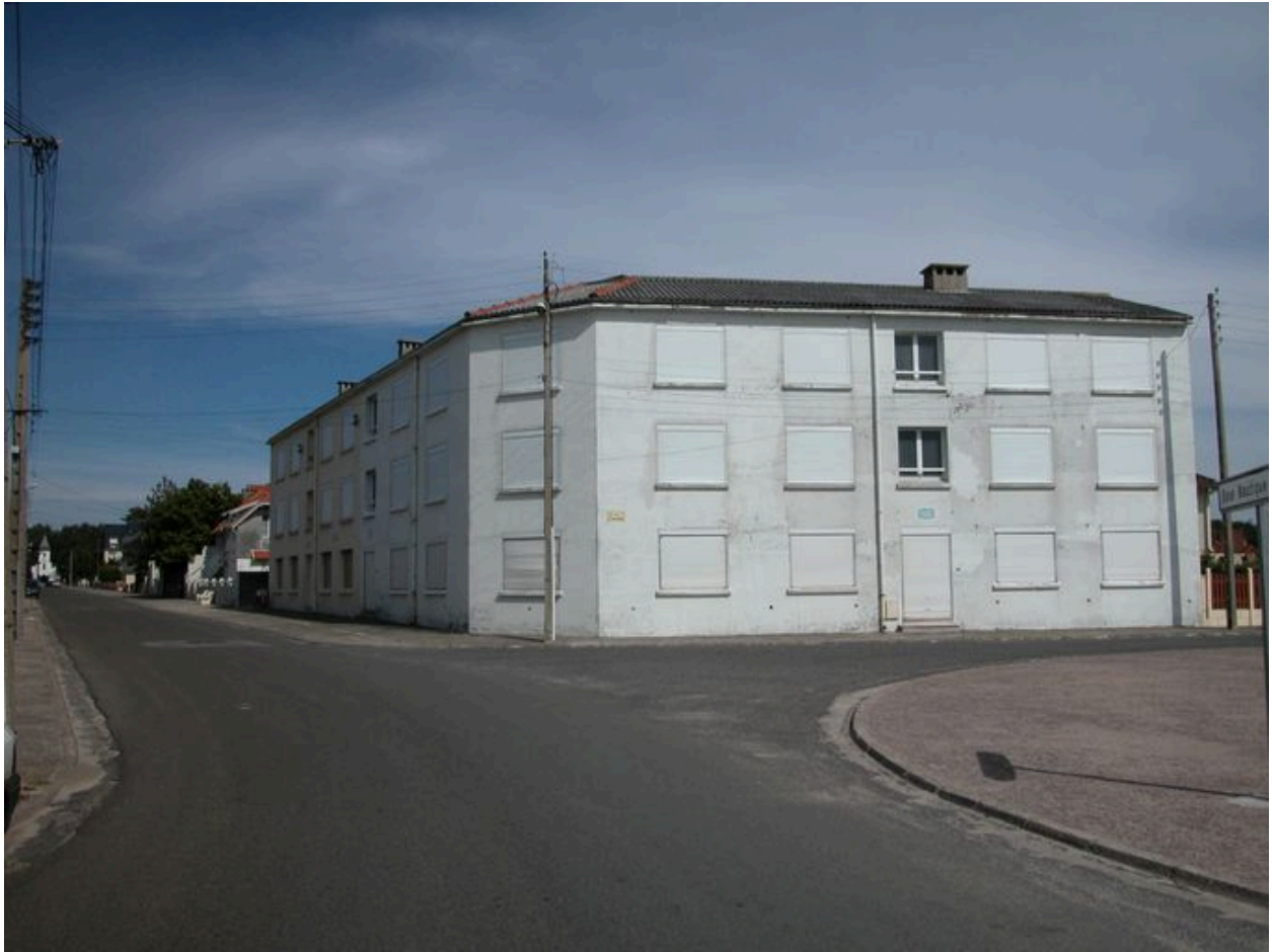
Ensemble de logements angle de l'avenue Courbet et de l'avenue Foch.
