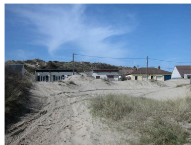
Les maisons au sud de l'îlot 18, vues depuis l'îlot 20. Phot. Elisabeth Justome IVR22_20058003982NUCA
