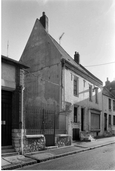
Vue de l'élévation sur rue. Phot. Pierre-Yves Brest IVR22_19990204356Z
