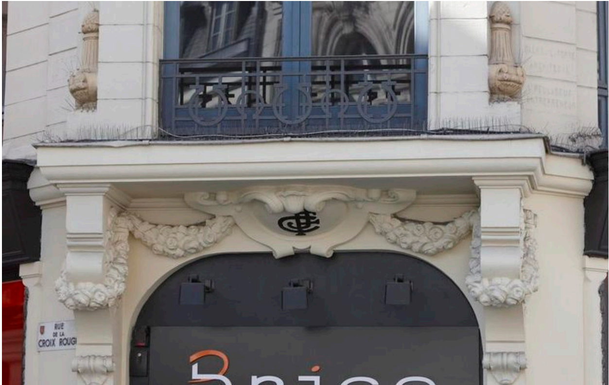
Guirlande de fleurs couronnant le rez-de-chaussée et encorbellement aux initiales du propriétaire des années 1920.
