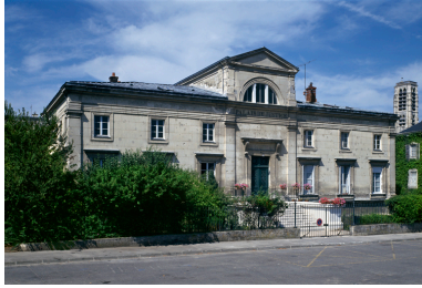
Vue générale depuis la place des Etats-Unis. Phot. Thierry Lefébure IVR22_19940200783XA
