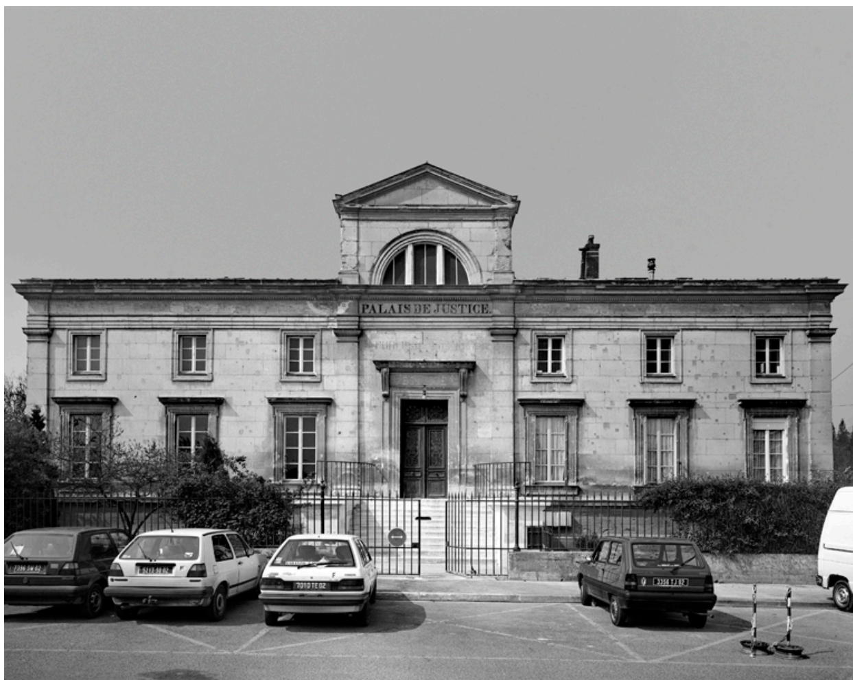
Vue de la façade sur la place des Etats-Unis.
