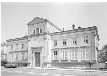
Élévation sur l'avenue de Soissons. Phot. Thierry Lefébure IVR22_19930200488X
