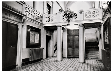
Vue d'ensemble de la salle des pas perdus en 1976 (cliché CRMH). Phot. Thierry Lefébure IVR22_19940202680XB
