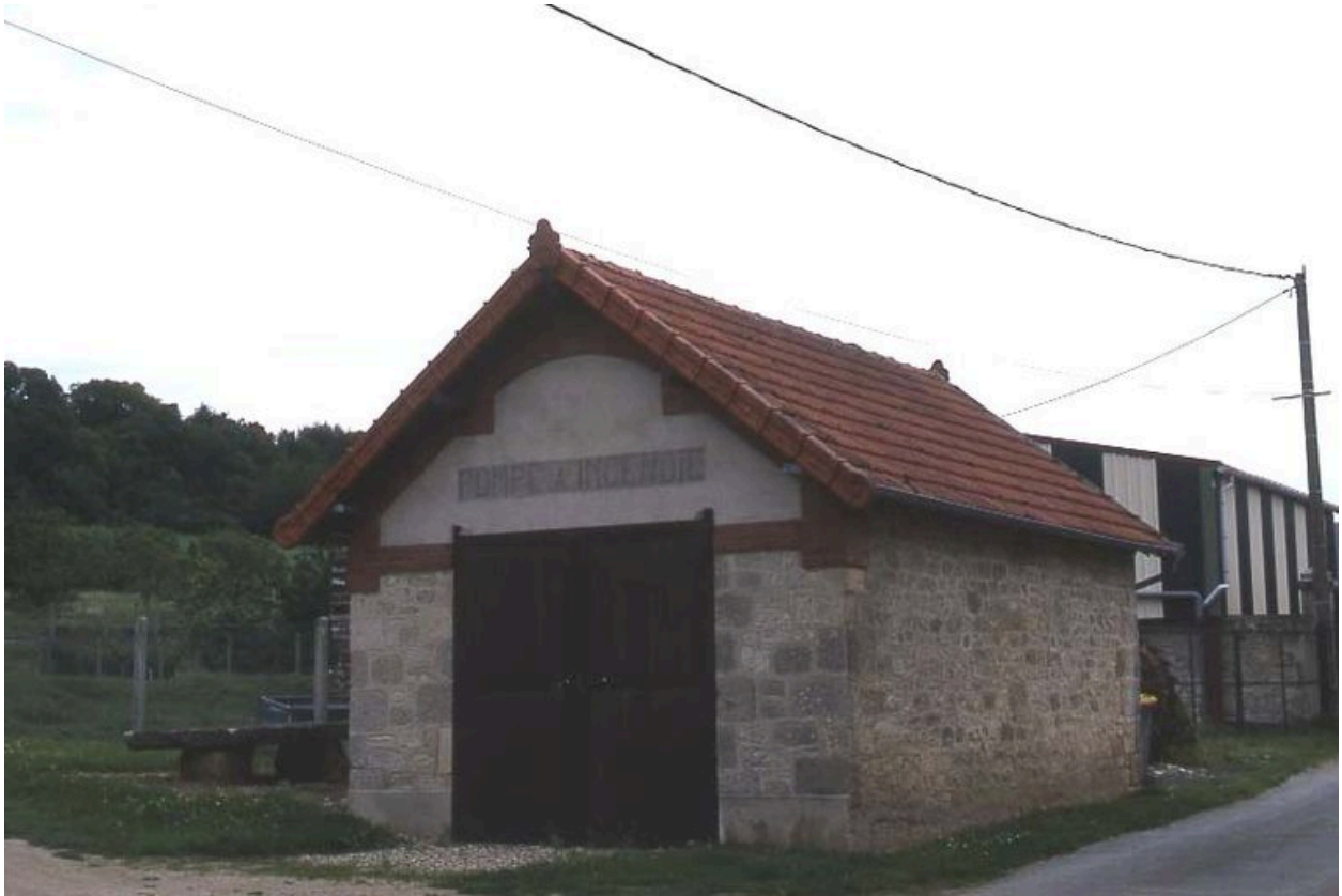
Vue du bâtiment de la pompe.
