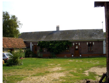
Vue du logis en fond de cour. Phot. Inès Guérin IVR22_20078005229NUCA
