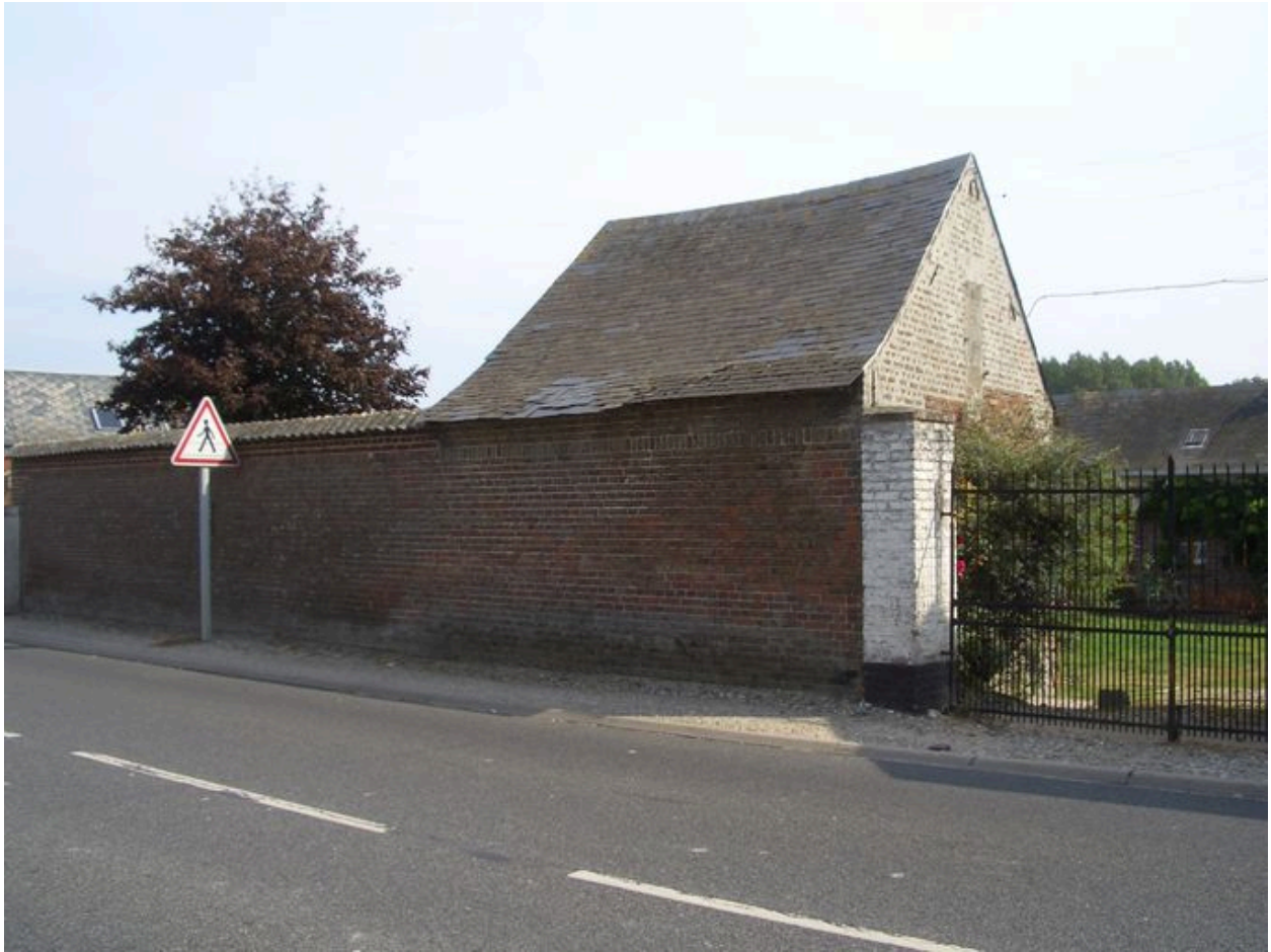
Vue du second bâtiment sur rue de l'autre côté de l'entrée.
