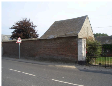
Vue du second bâtiment sur rue de l'autre côté de l'entrée. Phot. Inès Guérin IVR22_20078005228NUCA
