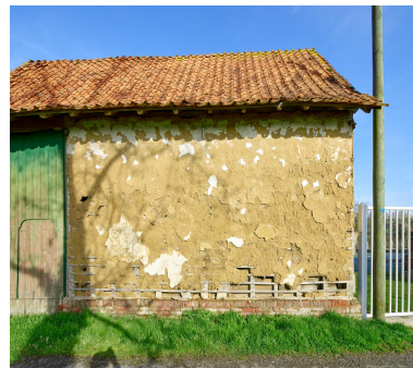
Détail du mur en torchis de la grange. Phot. Thierry Lefébure IVR32_20236200401NUCA
