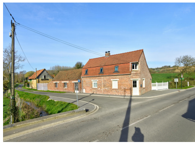
Vue générale depuis le sud-est. Phot. Thierry Lefébure IVR32_20236200398NUCA
