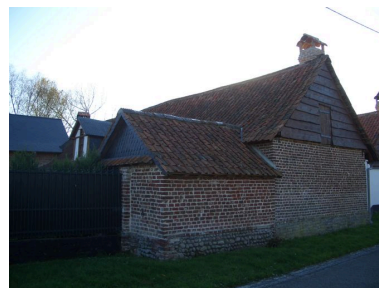
Vue des étables à vaches et à cochons depuis la rue. Phot. Inès Guérin IVR22_20078005067NUCA
