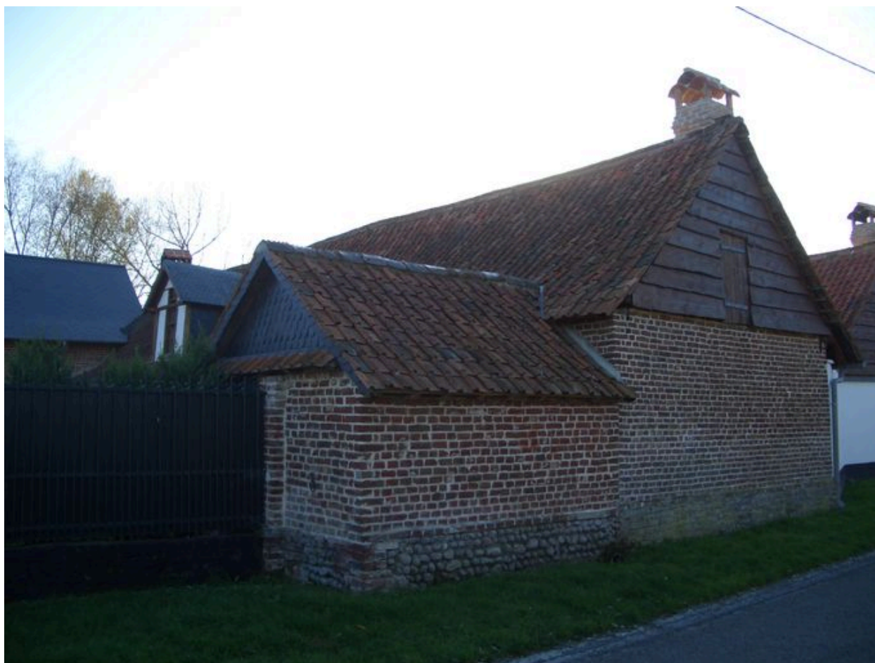
Vue des étables à vaches et à cochons depuis la rue.
