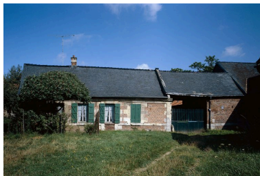
Élévation antérieure. Phot. Jean-Michel Perrin IVR22_19846001124XA
