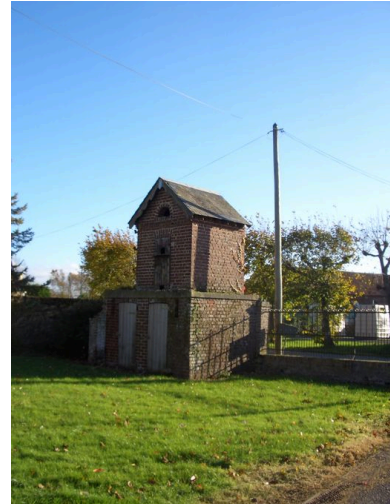
Vue du pigeonnier. Phot. Inès Guérin IVR22_20068005644NUCA
