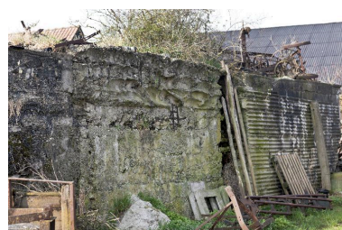
Elévation nord : empreintes de coffrages en tôles ondulées et sacs de sables Phot. Jean-Marc Ramette IVR31_20145905518NUCA
