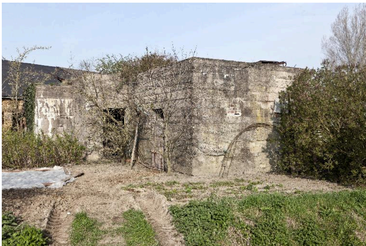
Vue de trois-quarts vers le nord-ouest
