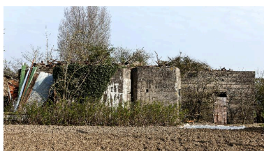
Elévation sud Phot. Jean-Marc Ramette IVR31_20145905522NUCA
