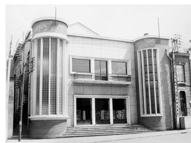
Élévation antérieure. Photographie ancienne, vers 1955. Photographie inconnu (AC Marpent). Repro. Thierry Petitberghien IVR31_20025900207XB
