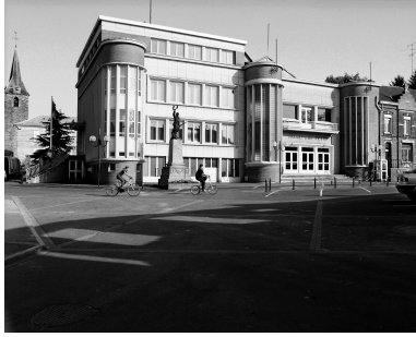
Élévation antérieure de la salle des fêtes (à droite). Phot. Thierry Petitberghien IVR31_20025900354X
