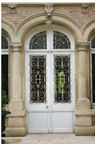
Porte d'entrée marquée des initiales HH. Phot. Thierry Lefébure IVR22_20128000848NUC2A
