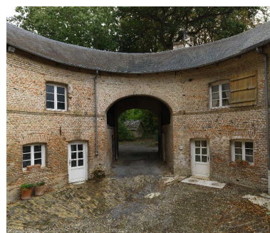
Vue du porche d'entrée des communs depuis la cour. Phot. Thierry Lefébure IVR22_20128000846NUC2AQ
