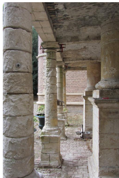
Détail des colones soutenant le balcon. Phot. Bertrand Fournier IVR22_20128005340NUCA
