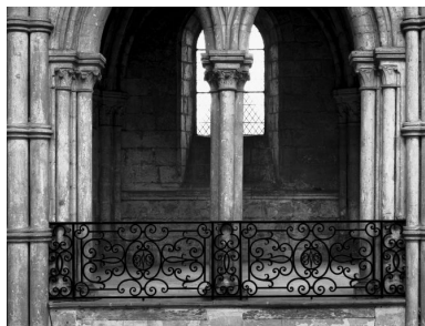
Vue d'un des garde-corps. Phot. Jean-Michel Périn IVR22_19846000920V
