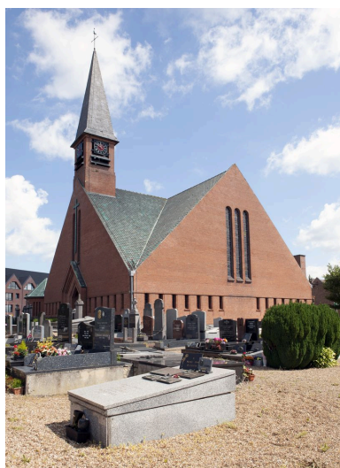
Vue extérieure du flanc droit. Phot. Pierre Thibaut IVR31_20155900945NUCA
