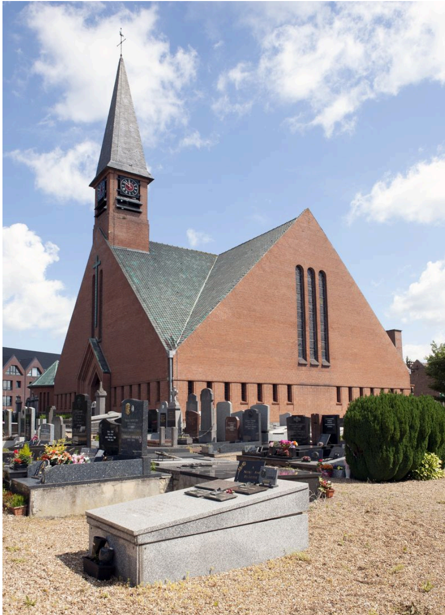
Vue extérieure du flanc droit.
