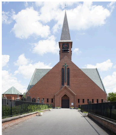
Élévation antérieure. Phot. Pierre Thibaut IVR31_20155900949NUCA
