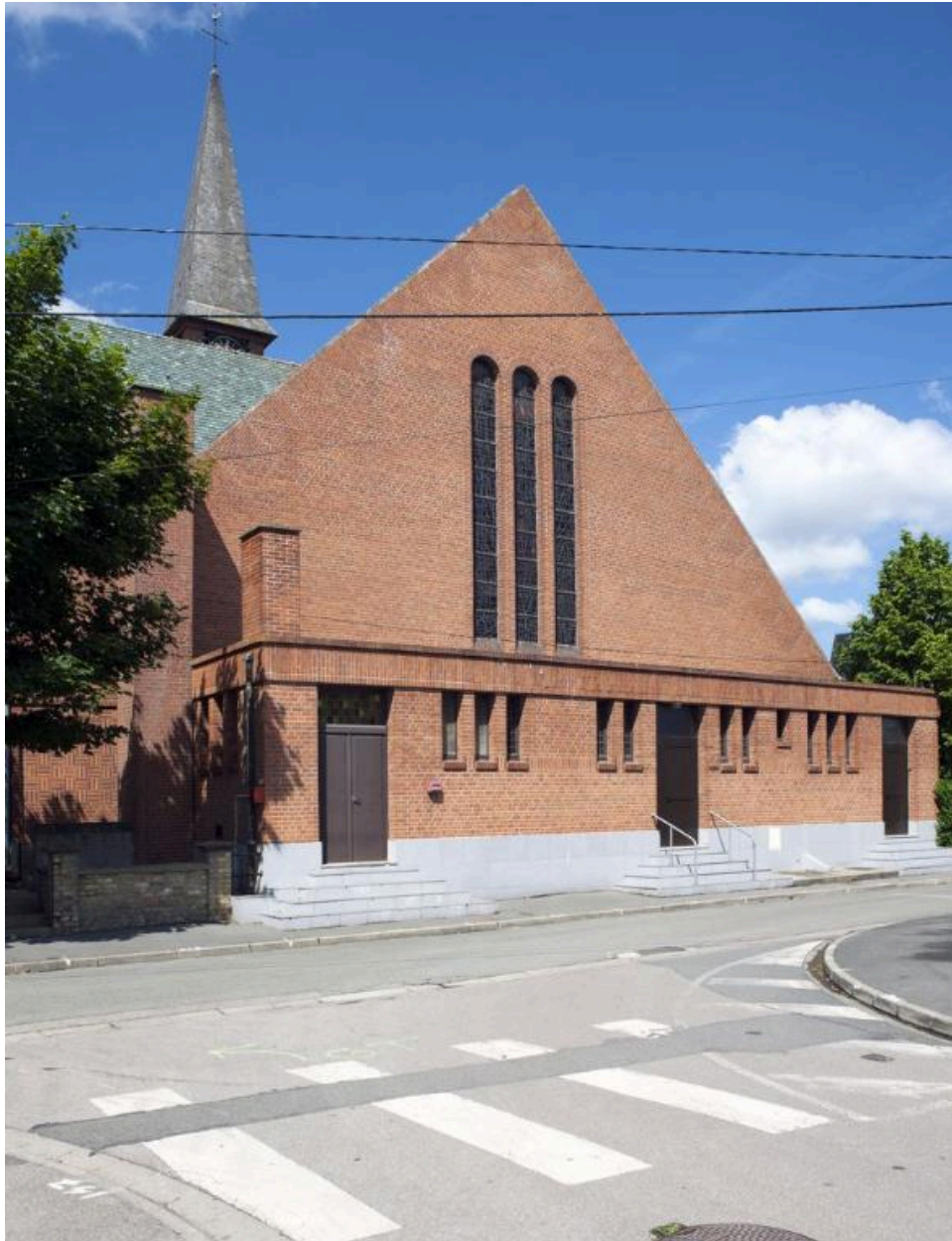
Élévation postérieure de l'église.
