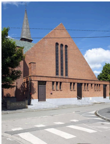
Élévation postérieure de l'église. Phot. Pierre Thibaut IVR31_20155900946NUCA
