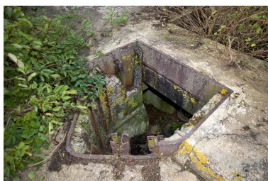
Un des deux observatoires cuirassé, privé de son couverment. Phot. Jean-Marc Ramette IVR32_20176200553NUCA
