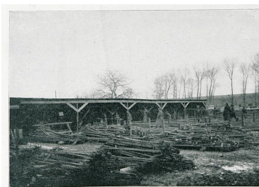
Atelier de cintrage des fers à béton. in: Deutsche Frontbauarbeit im Kriege, p.127 Phot. Staatsbibliothek zu Berlin (reproduction) IVR32_20176200523NUCA
