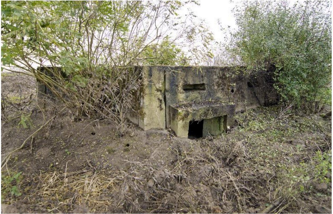
Entrée sud surmontée de sa banquette de tir.
