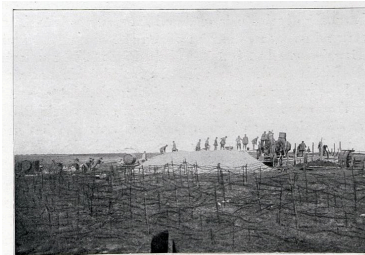
Mise en place de la bétonnière. In: Deutsche Frontbauarbeit im Kriege, p.135
