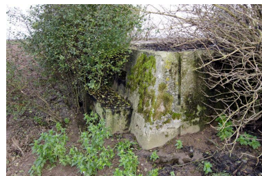
L'entrée nord, sa banquette de tir et sa niche à munitions, vers le sud Phot. Jean-Marc Ramette IVR32_20176200547NUCA
