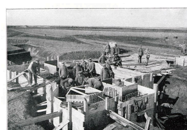
Coffrage des murs de l'édifice. In: Deutsche Frontbauarbeit im Kriege, p.130 Phot. Staatsbibliothek zu Berlin (reproduction) IVR32_20176200529NUCA
