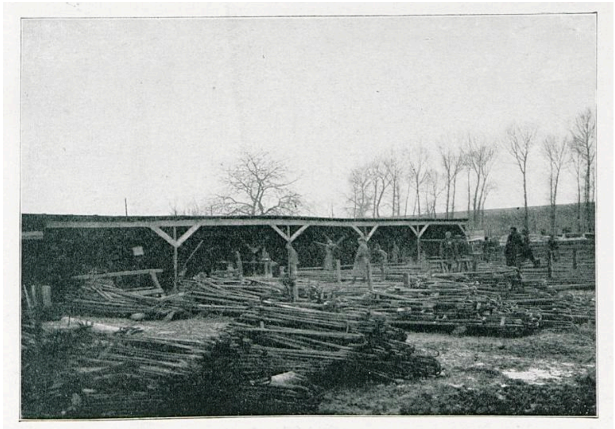
Atelier de cintrage des fers à béton. in: Deutsche Frontbauarbeit im Kriege, p.127
