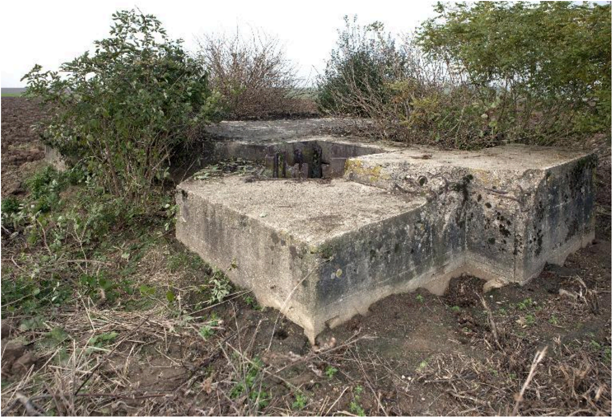
Coin sud-ouest de l'édifice, vers le nord. On aperçoit une partie de l'observatoire cuirassé.
