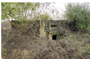
Entrée sud surmontée de sa banquette de tir.
