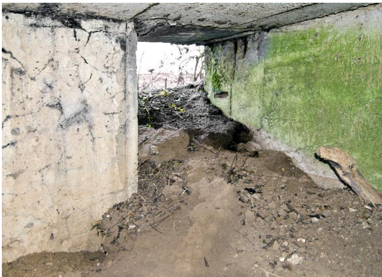
Couloir sud, vers l'extérieur
