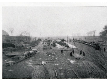
Parc à matériaux de Fontaine-lez-Croisilles (62). Fers à béton. in: Deutsche Frontbauarbeit im Kriege, p.128 Phot. Staatsbibliothek zu Berlin (reproduction) IVR32_20176200525NUCA
