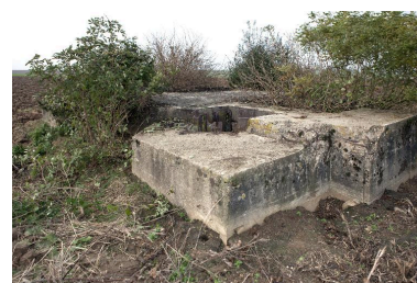
Coin sud-ouest de l'édifice, vers le nord. On aperçoit une partie de l'observatoire cuirassé. Phot. Jean-Marc Ramette IVR32_20176200554NUCA
