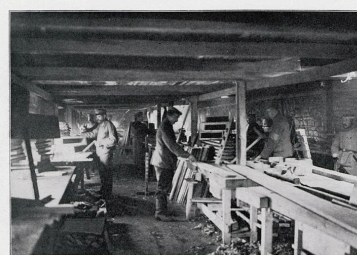
Atelier de menuiserie. Ici sont façonnés les éléments de coffrage. in: Deutsche Frontbauarbeit im Kriege, p.128 Phot. Staatsbibliothek zu Berlin (reproduction) IVR32_20176200524NUCA
