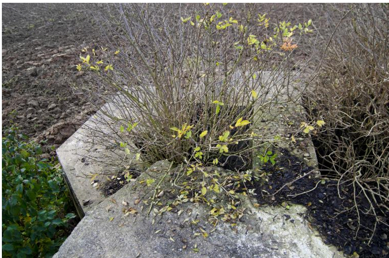
Vue plongeante sur l'observatoire cuirassé nord, depuis le couvrement
