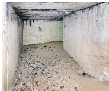
Couloir d'entrée sud, en grande partie comblée Phot. Jean-Marc Ramette IVR32_20176200541NUCA
