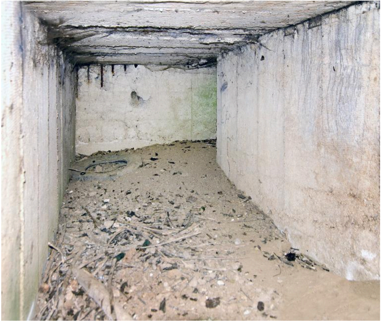
Couloir d'entrée sud, en grande partie comblée
