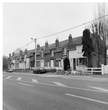
Logements d'ouvriers. Phot. Olivier Marlard IVR31_19895900431X
