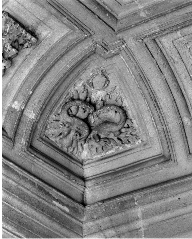
Caisson d'angle orné de deux salamandres couronnées. Phot. Thierry Lefébure IVR22_19900202215X
