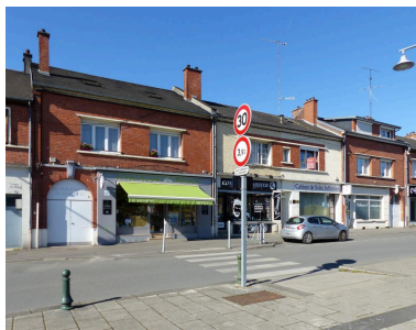
Composition symétrique de trois maisons à boutique, 5 à 9 avenue Jean-Moulin. Phot. Isabelle Barbedor IVR32_20220205071NUCA
