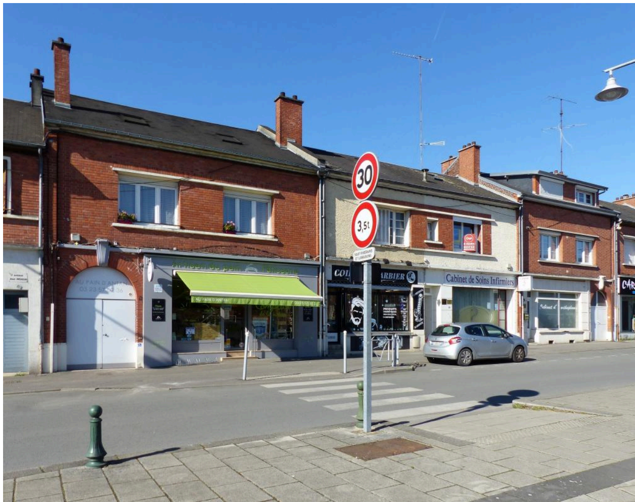
Composition symétrique de trois maisons à boutique, 5 à 9 avenue Jean-Moulin.
