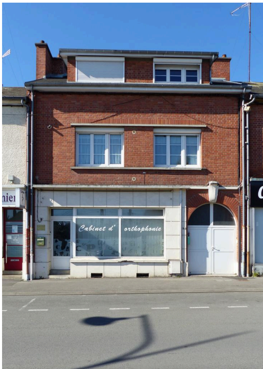
Maison à boutique à portail latéral, 9 avenue Jean-Moulin.
