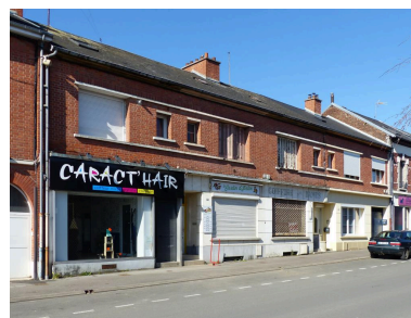
Maison à quatre unités d'habitation, 11 à 17 rue Jean-Moulin, avec passage latéral donnant accès à une maison en coeur de parcelle. Phot. Isabelle Barbedor IVR32_20220205070NUCA
