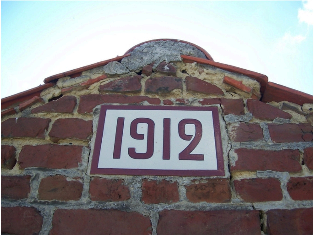
Détail de la remise à charbon, cartouche céramique millésimé.
