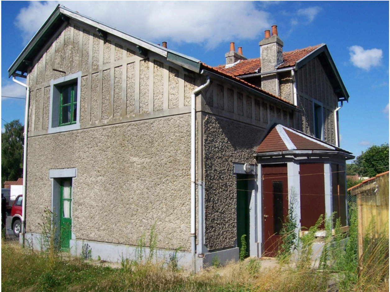
Vue de trois quarts de la façade postérieure.
