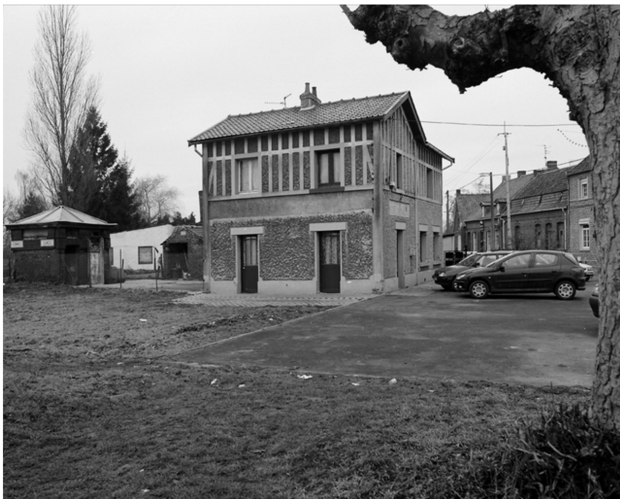
Vue générale, depuis la rue Jacques-Varlet.
