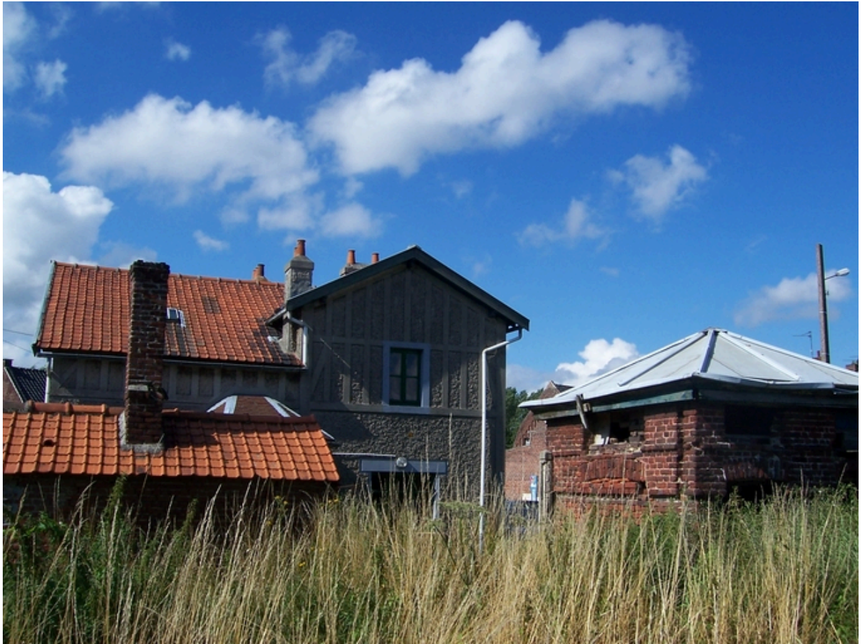
Vue générale de trois quarts arrière depuis le quai.
