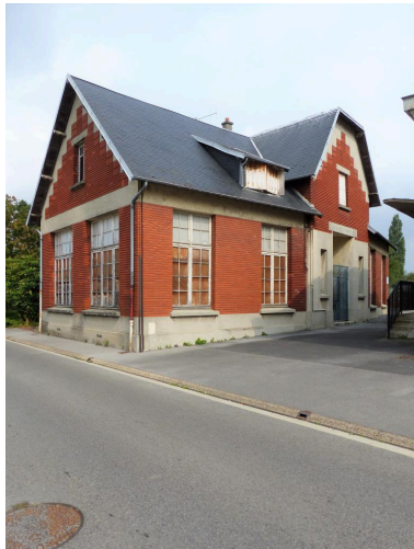
Vue générale depuis la rue Fernand-Bouyssou. Phot. Isabelle Barbedor IVR32_20210205113NUCA
