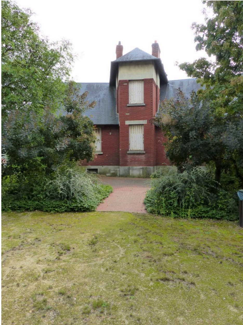
Vue de situation depuis le jardin au nord.
