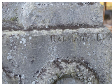
Vue de détail sur la signature de Jean-Baptiste Galmant. Phot. Isabelle Barbedor IVR32_20168006434NUCA
