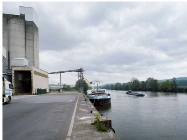
Cellules de stockage et quais de transbordement au bord de l'Oise. Phot. Thierry Lefébure IVR22_20106000291XA
