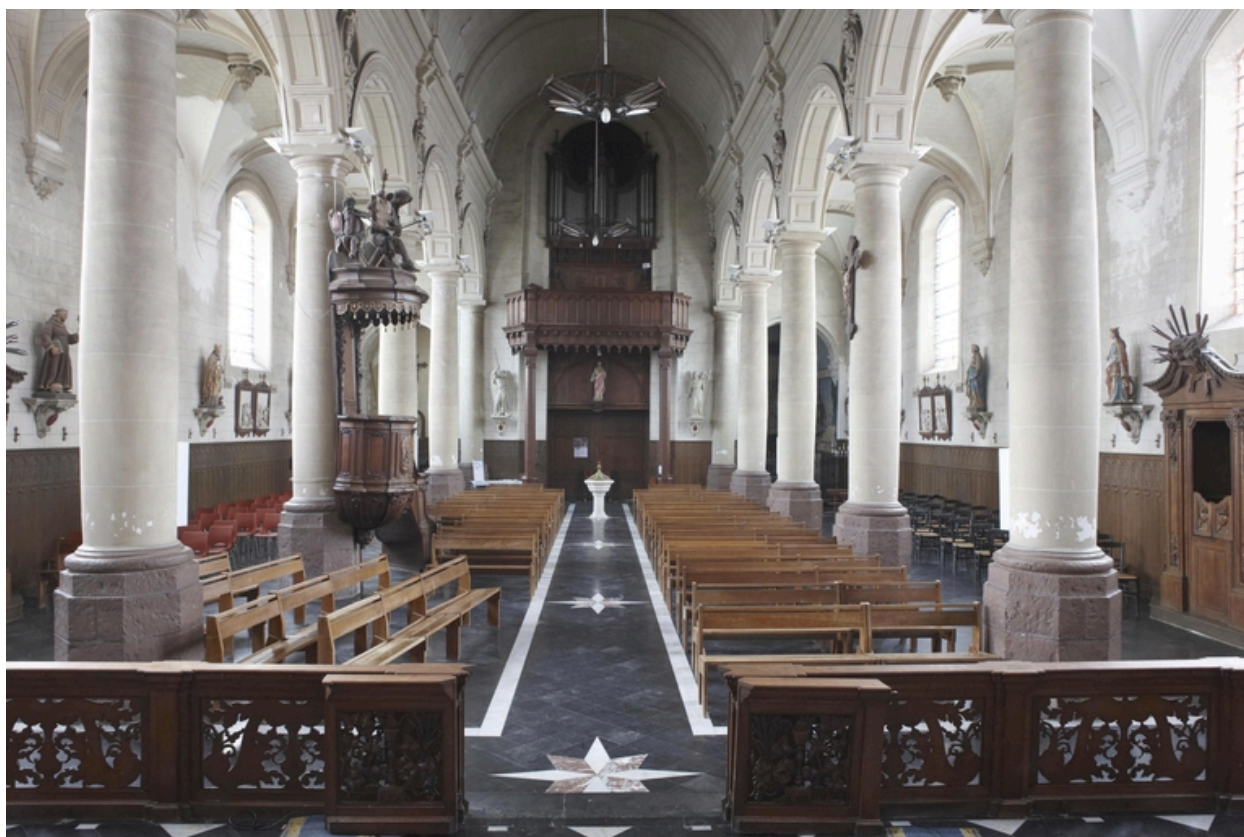
Vue générale intérieure, vers l'entrée.
