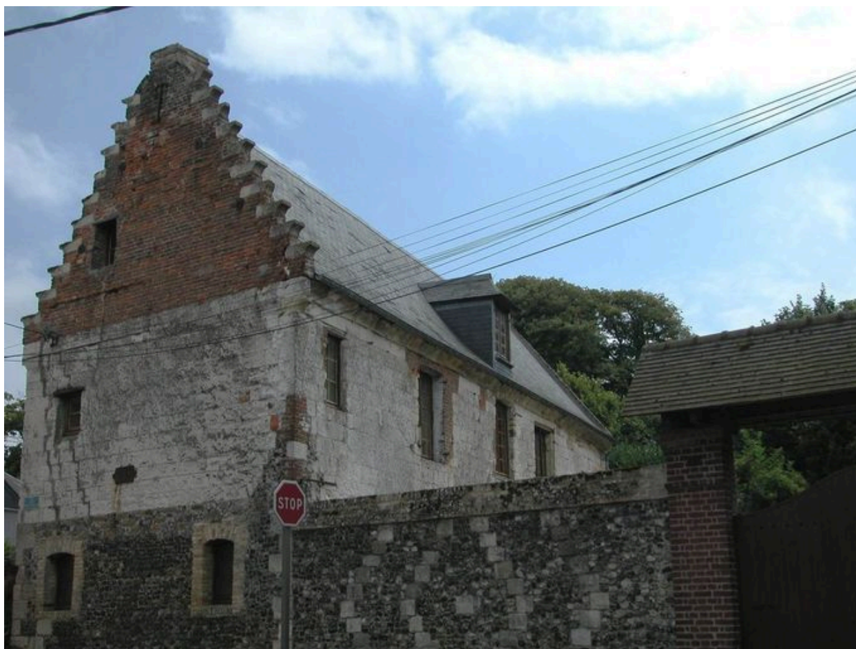
Maison dite de Fénélon, ancien logis de l'abbé (fin XVIe s.), construite en pierres avec pignon à redents en brique.
